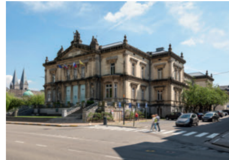
Die Anciens Bains von 1862, ein ehemals bedeutendes Gebäude im Stadtzentrum, steht seit Jahren leer und ist im schlechtem Zustand. Gebadet wird heute in den neuen „Thermes de Spa“ oberhalb der Stadt. Lageplan im Maßstab 1:50.000
